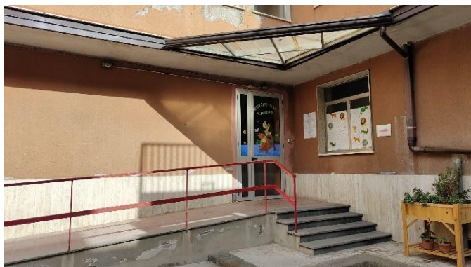
Figura 5: Plesso sede centrale "Giovanni Paolo II"
